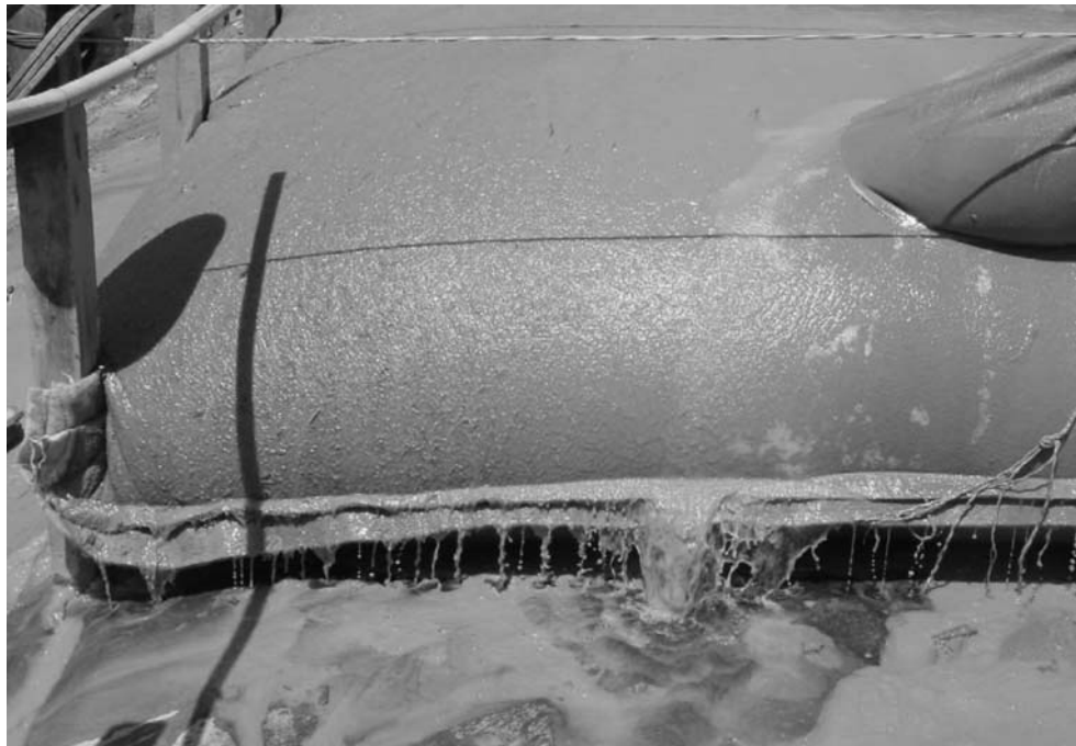
Gambar 2.26 Rembesan air yang keluar dari tube berisi lumpur.
