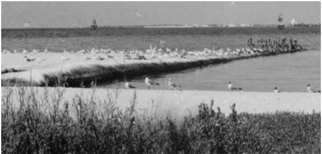
Gambar 2.22 Kondisi geotube Agustus 1995 ( 6 bulan setelah Instalsi )
