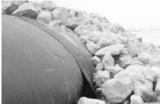
Gambar 2.9 Geotube dan Rip – rap
