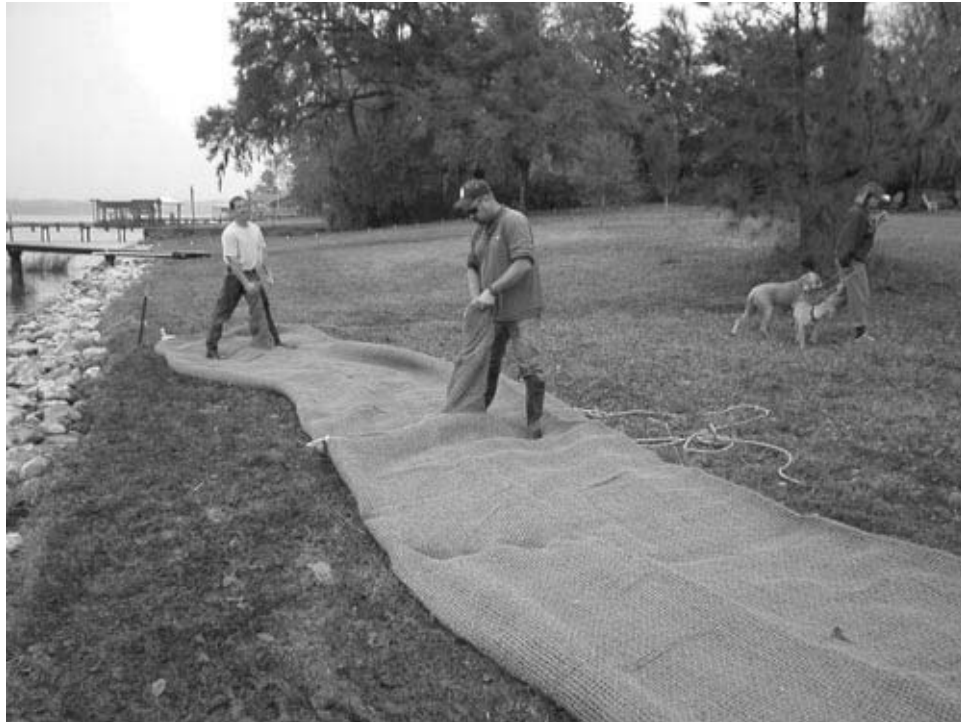
Gambar 2.29 Tube sepanjang 40 kaki dengan keliling 4 meter dipersiapkan.
