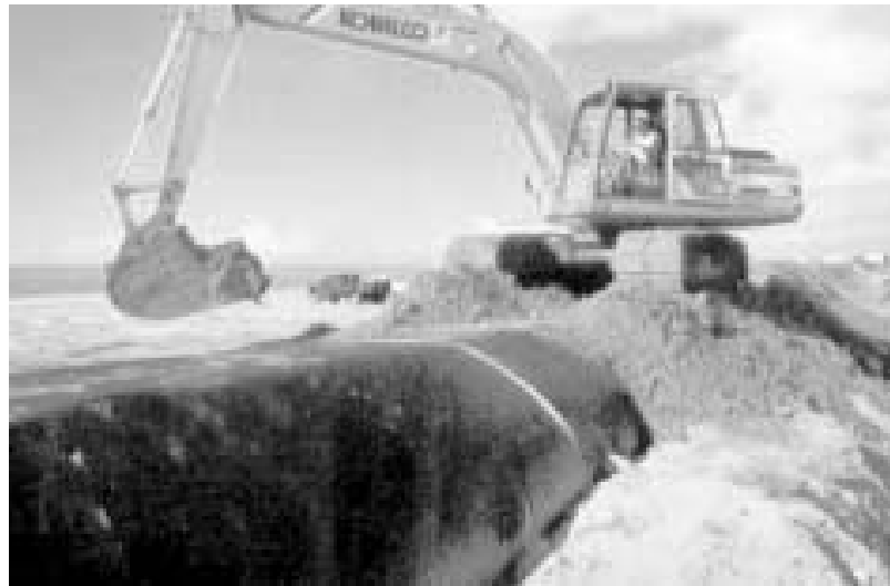
Gambar 2.18 Penutupan tube dengan pasir, Bolivar Peninsula.
