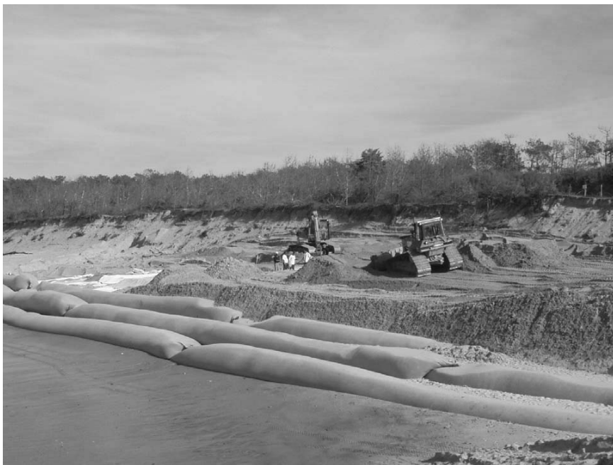
Gambar 2.39 Struktur geotube sebagai Proteksi terhadap Erosi , Emelie Beach.
