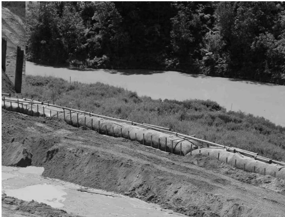
Gambar 2.24 Tampak atas konstruksi geotube Cameron Highland, Malaysia.
