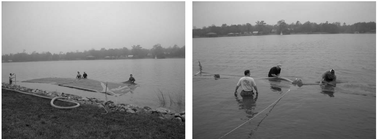
Gambar 2.30 Instalasi geotube di atas apron yang mengambang..
