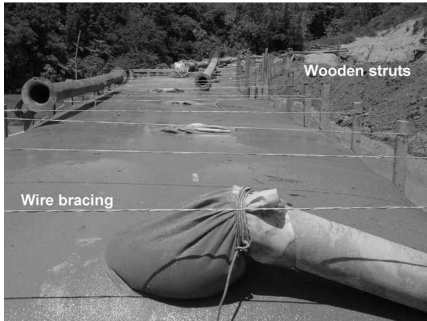
Gambar 2.14 Pengisian Tube dengan bekisting kawat dan kayu
